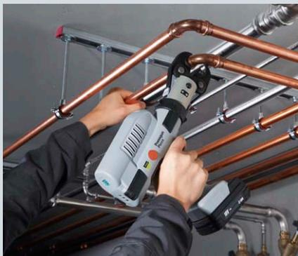
2. So hat man beim Anlegen der Pressbacke eine Hand zum Ausrichten oder Fixieren der Installation frei.
