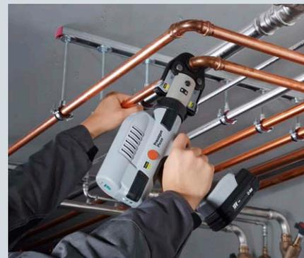
3. Beim ersten Auslösen des Startschalters schließt die Pressbacke automatisch. Beim zweiten Auslösen wird verpresst.
