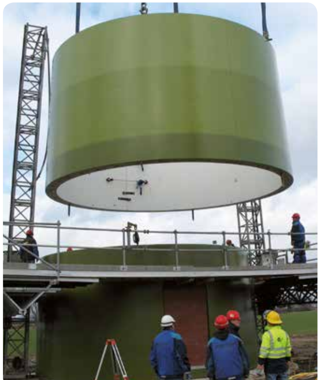
Montage von Windkraftanlagen
