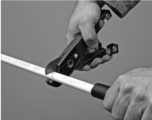
Schutzrohr und Innenrohr mit Kombischere 4837.xxx ablängen.
