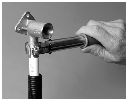
Bördel-Verschraubung mit dem Ratschen-Drehmomentschlüssel 5790.003 / 5792.003 bis zum hörbaren „Klick“ anziehen.
