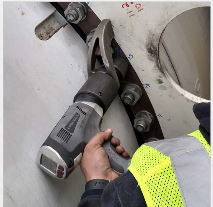
Flügelverschraubung Windrad
