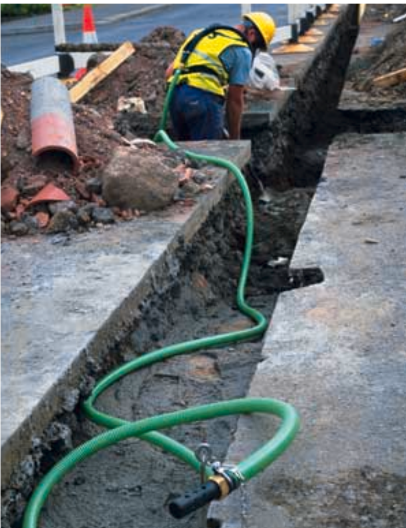
Turbo-Flo als Saugschlauchgerät
