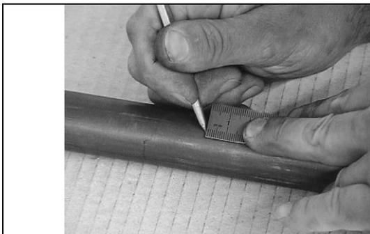
Mit einer Reißnadel oder einem Stift das Maß auf dem Rohr markieren.
