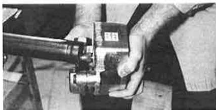
**4** Überprüfen Sie den Nutdurchmesser, nachdem Sie das Gerät vom Rohr abgebaut haben, um zu gewährleisten, dass die Nut den Nutdurchmesserspezifikationen entspricht.
