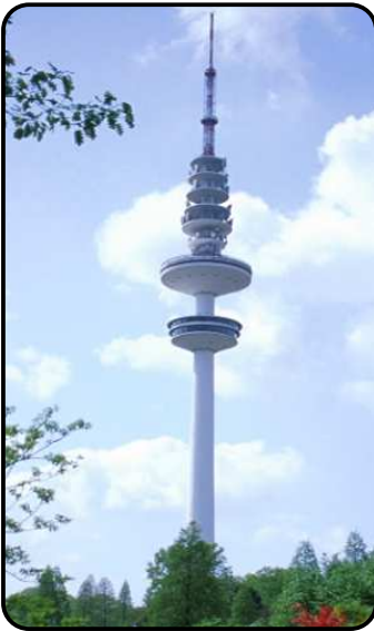
Tausende von Fernseh- und Rundfunksendern mit hoher Sendeleistung sind im Einsatz.
