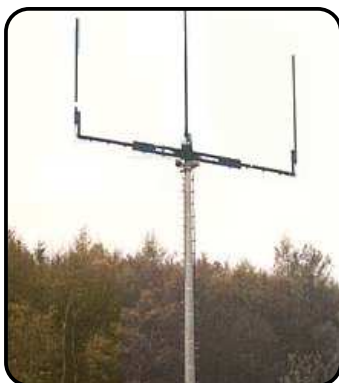
Rundstrahlende Basisstation mit einer Zelle.
