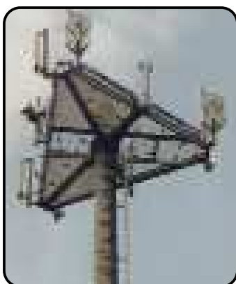
Sektor-Basisstation mit 3 Funkzellen. Jede Zelle bestrahlt einen 120 Grad Sektor.
