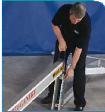
Ein Ende der Lasttraverse mit der hinteren Bohrung im Rahmenblech (Schraube 1) ausrichten und eine Schraube einstecken. Die Unterleg- und Federscheiben sowie Mutter einsetzen und fingerfest anziehen.
