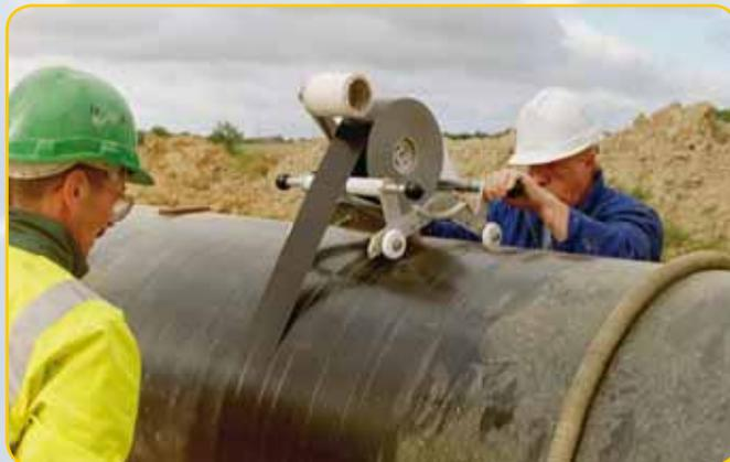
Nachisolierung von Schweißverbindungen auch an großen Rohrdurchmessern
