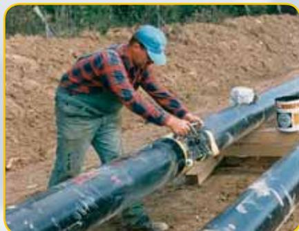
Nachisolierung von Schweißverbindungen mit kaltverarbeitbaren Kunststoffbändern
