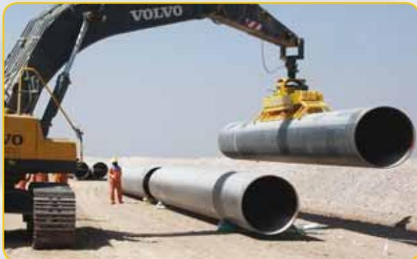
VACUVIETZ im Baggereinsatz mit hydraulischem Drehkopf
