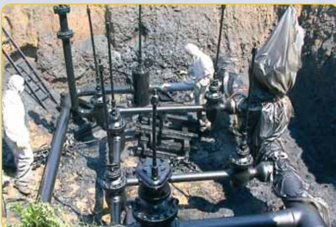
Umhüllungssanierung komplexer Bauteile mit Polyurethan-Heißspritzbeschichtung
